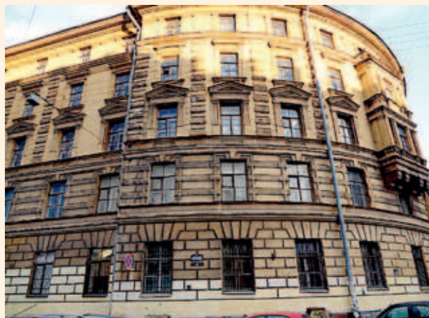
▼ Дом для работников Госбанка, Петербург, канал Грибоедова, д. 22. 1880-1883 гг.
